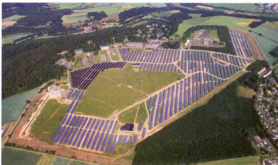
Eine von zwölf Solaranlagen im Kombikraftwerk 2. Im Szenario des IWES soll die Solarenergie einmal 20 Prozent des benötigten Grünstroms liefern.
